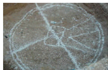
Replanteo depósito
