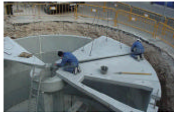
Colocación sectores prefabricados
