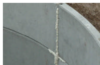
Sellado juntas con espuma de poliuretano
