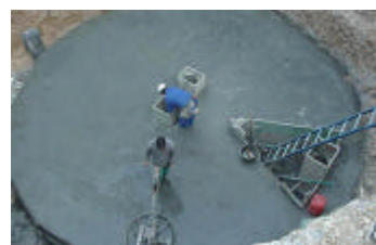
Esperas para torre-pilar
