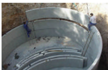
Colocación dovelas
