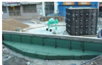
Impermeabilización antiárbol
