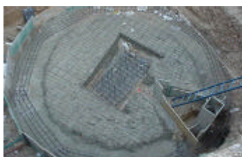
Losa agrupe zapatas y arquetas
