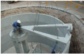
Sectores cubierta: hueco elevador
