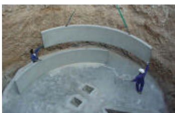
Acopio muros prefabricados
