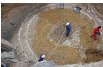
Zapata perimetral y central
