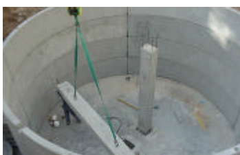
Colocación pilares centrales
