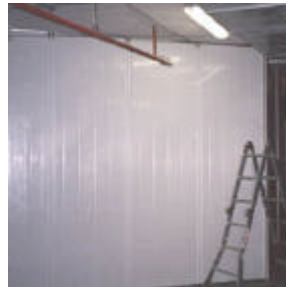
Tabiquería cerramiento en sótano
